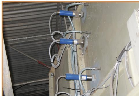
In cementificio per riempimento pre-hopper: livello minimo, massimo e super massimo.
