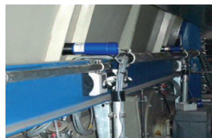
Rilevazione cemento in uscita bunker
